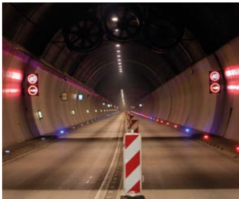
Sodelovali so pri opremljanju tunela Karavanke
